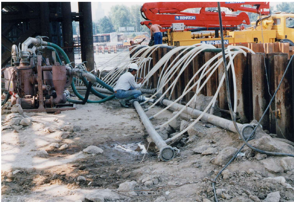
Rys. 6. Instalacja chłodząca na fundamencie pylonu Mostu Świętokrzyskiego
