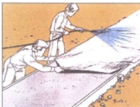
Rys 1. Nakładanie mat i ich zraszanie
