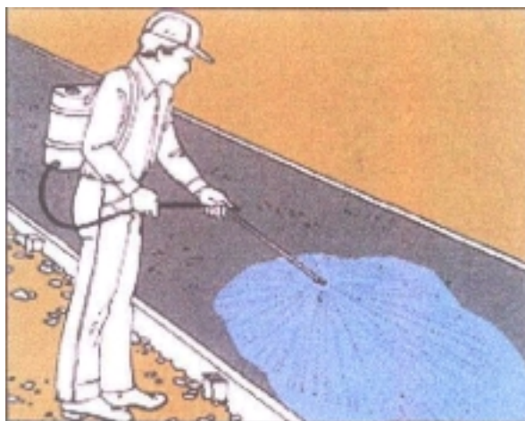
Rys 3. Mechaniczne natryskiwanie preparatu błonkotwórczego
